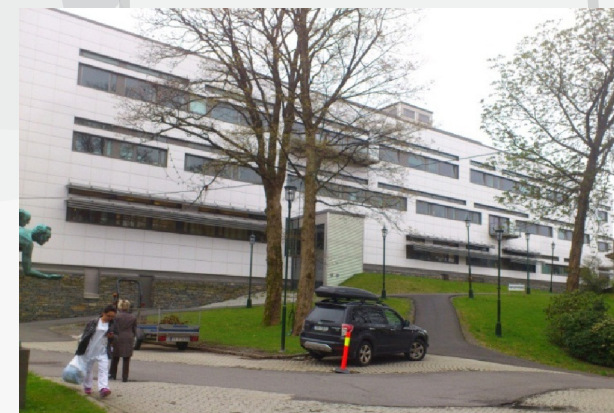
Bilde av Parkbygget
